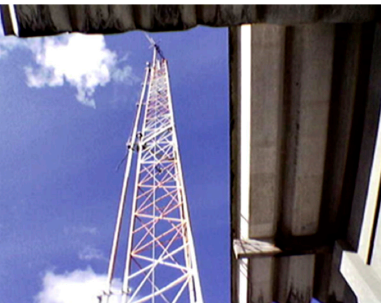
Torre de Rádio em Subestação Elétrica (cabo do para-raios inexistente - roubo)
